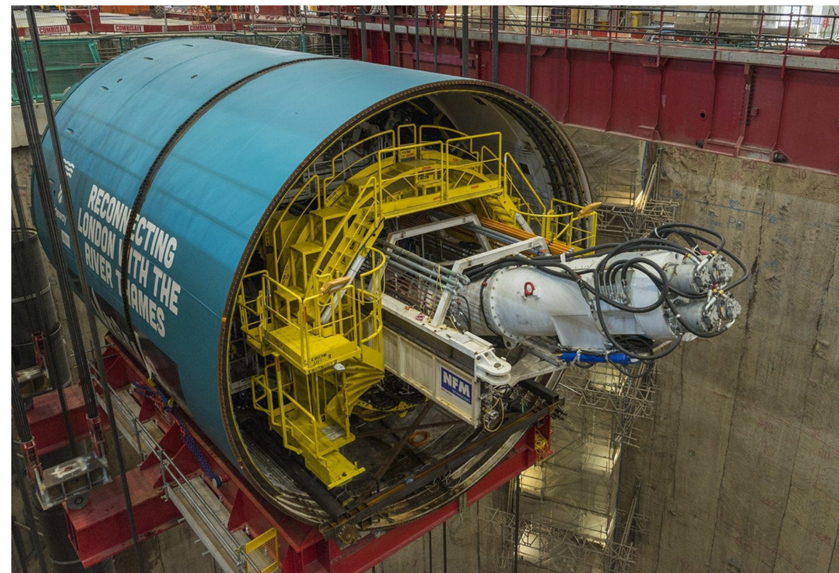
Túnel de Thames Tideway, tramo central. Londres, Reino Unido: Ferrovial.
