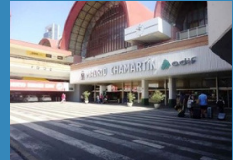
ESTACIÓN CHAMARTIN ADIF
